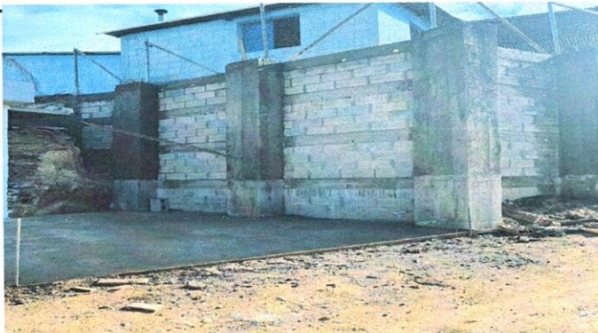
Foto 4: Se observa los drenes en todo el área del muro de contención, el grosor de columnas, la altura, apreciando un muro fuera de peligro.
