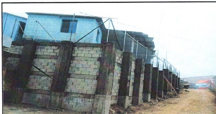
Foto 3: se aprecia la altura, el ancho y columnas resistentes en la unión de los muros suroeste
